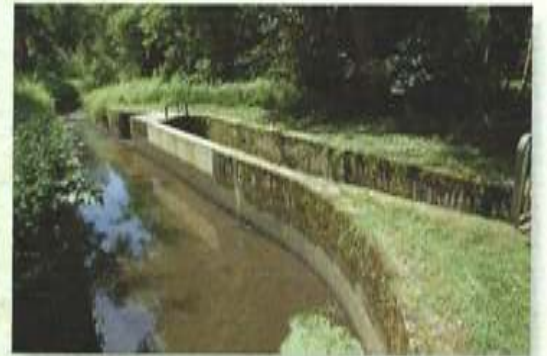
Federbach: Schleife, Bauwerk zur Überleitung von Wasser über den Haftgraben zum Alten Federbach
