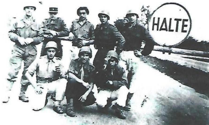
Schlagbaum am nördlichen Ortsausgang
