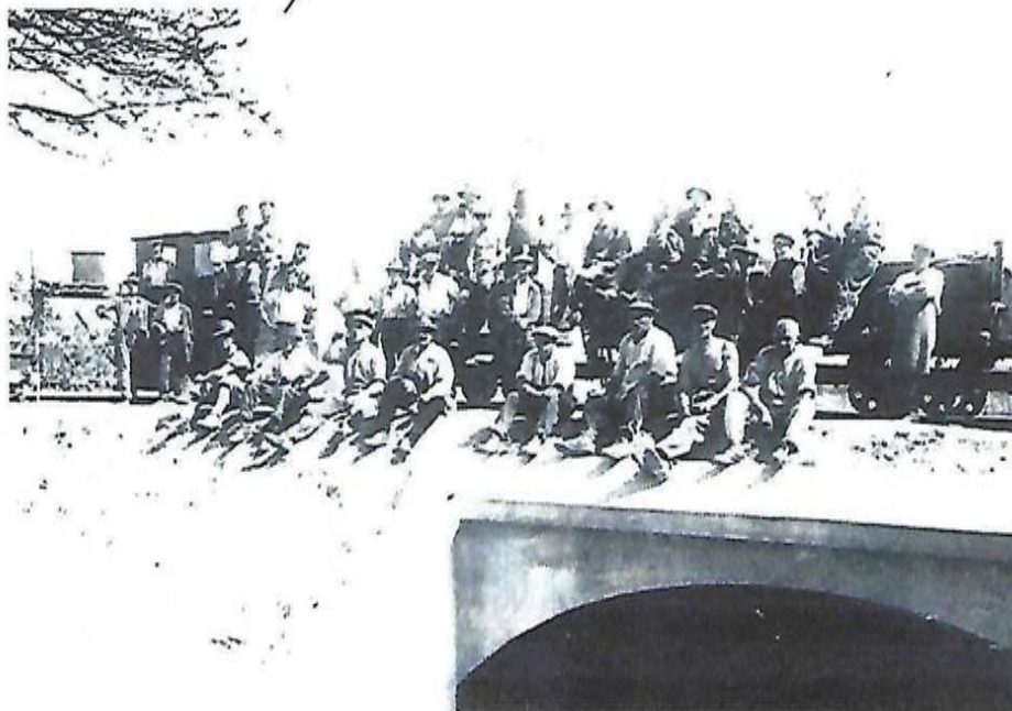
Notstandsarbeiten am Federbach
