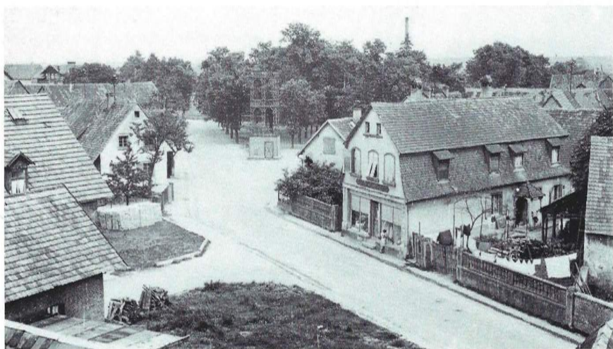
Ein Blick in die Ettlenger Straße mit dem Übungsgerüst der freiwilligen Feuerwehr (um 1930).
