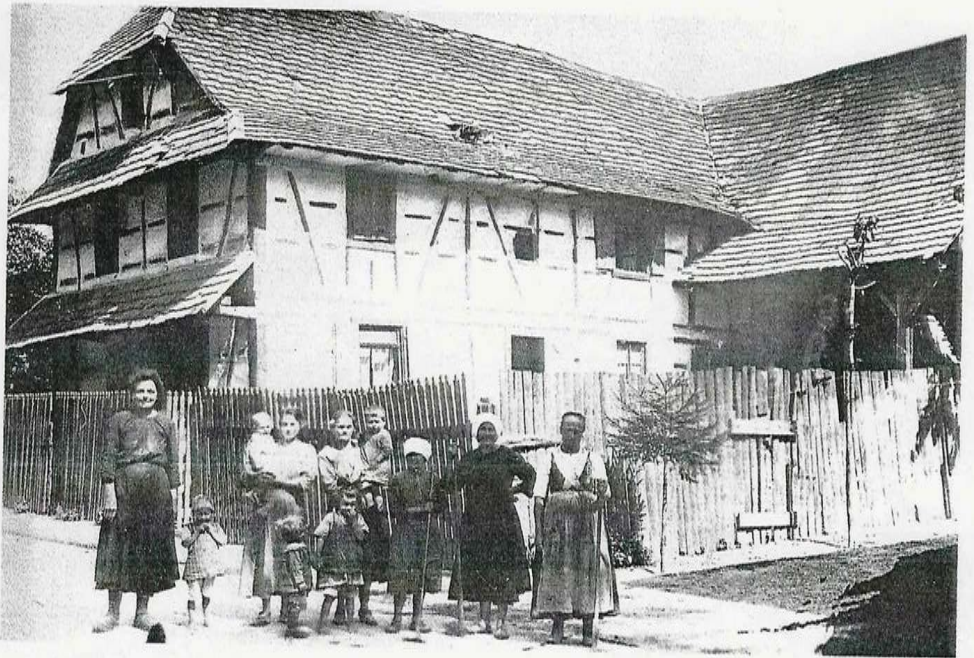
Ehemaliges Haus Lorenz Schorpp an der Haupt- straße in Wür- mersheim; inzwi- schen leider abge- rissen, wie fast alle seiner Art.
