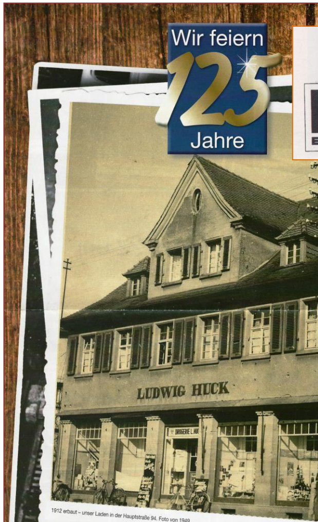
1912 erbaut - unser Laden in der Hauptstraße 94. Foto von 1949
