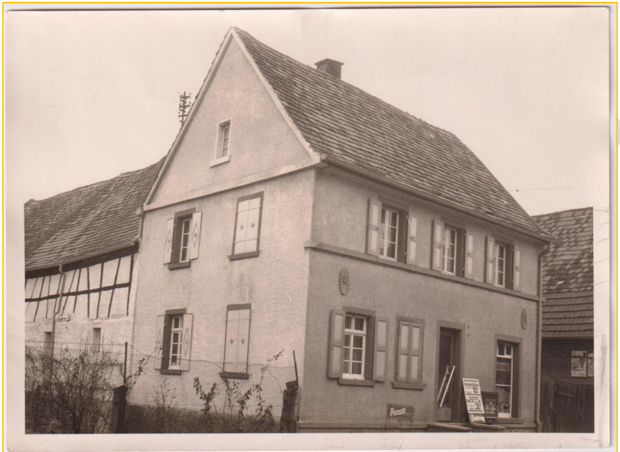
Hammer, Wilhelm („s Hommer-Helme“) Hauptstraße 43, heute Parkplatz RaiBa
