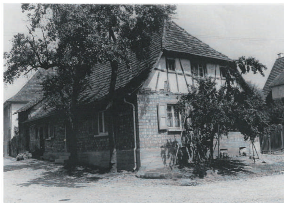
Erstes Schulhaus Ecke Ritter- Thomasstraße
