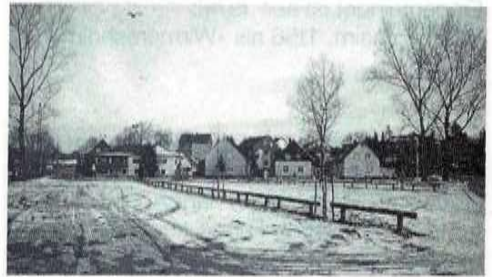
Abb. 42a: Fundstelle »Im Eck« – Zustand 1987.
